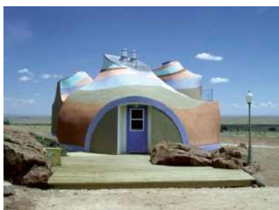
Rock Hill house , premier revêtement du toit, New Mexico. 2003.
