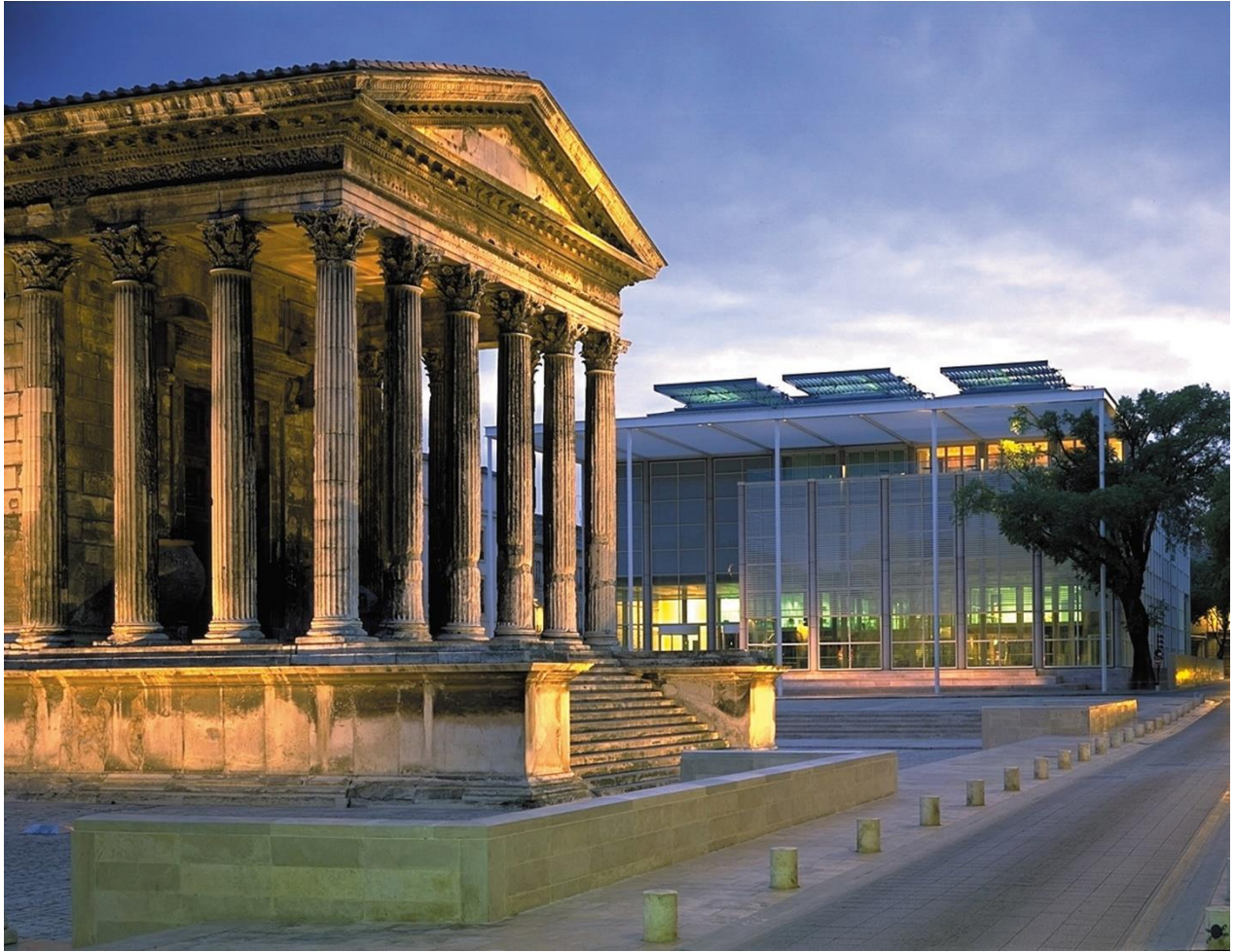
Annexe 4 | Environnement immédiat de Carré d'Art, avec le face à face des deux architectures.
