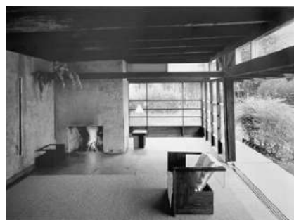
Rudolph SCHINDLER, Schindler house , 1922, vue intérieure.
